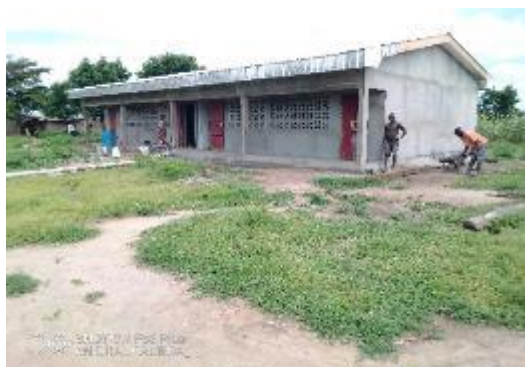
Construction à l'Ecole publique de Djanga
