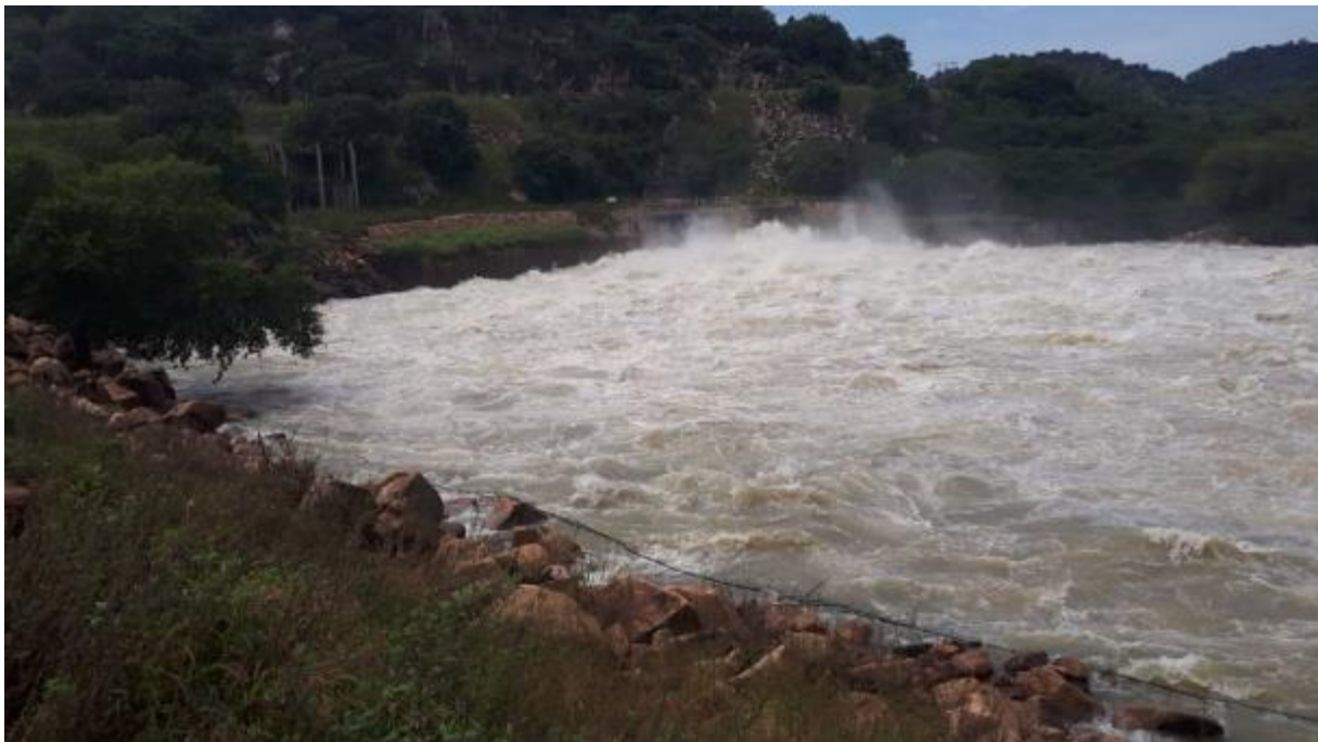
Figure 17 : Lâchures du 23/10/2019 au niveau du tunnel d'évacuation
